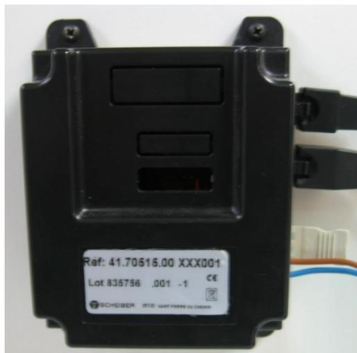
**Etape 6** – Vérifier le fonctionnement du coffret à l'aide du bouton poussoir du coffret. Une impulsion pendant quelques secondes permet au sélecteur ABB de changer d'état.
